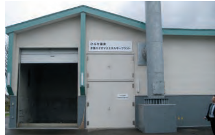
有効活用したい木質バイオマスボイラー
