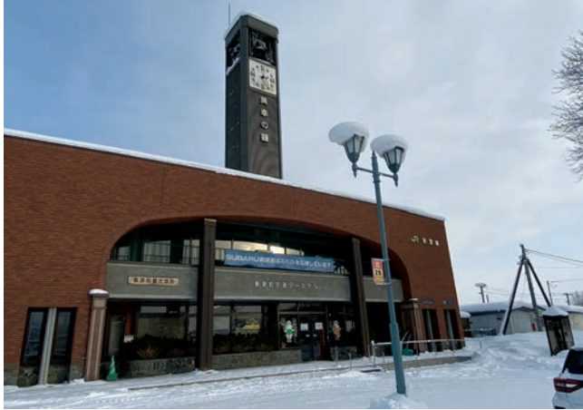
復旧が待たれる駅前の街灯
