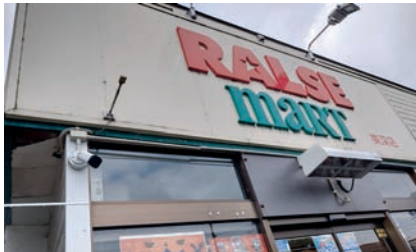
大通りに屋外防犯カメラ設置は少ない
