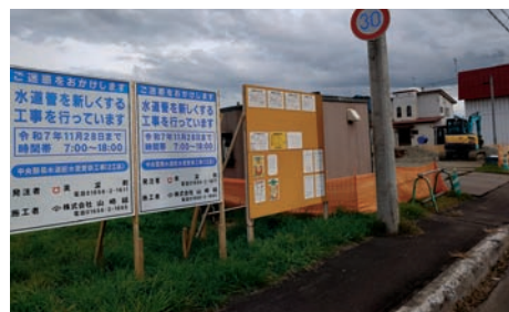
水道管更新工事が進む
