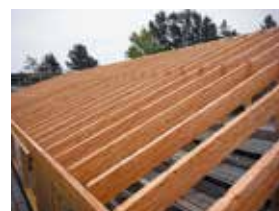
傾斜屋根を支える集成材の梁。
