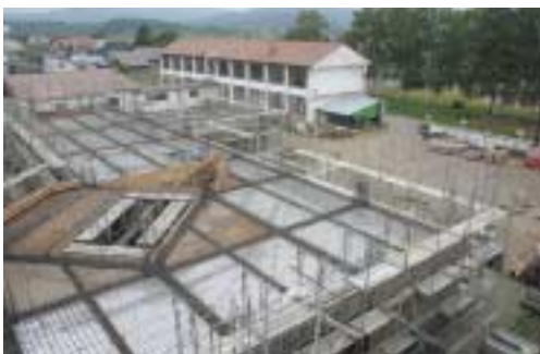
▲新校舎の改築工事が進む美深小学校
