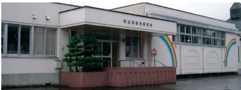
高齢者住宅に改修される旧恩根内保育所
