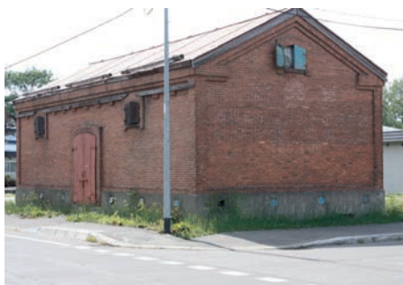
解体されたレンガ倉庫
