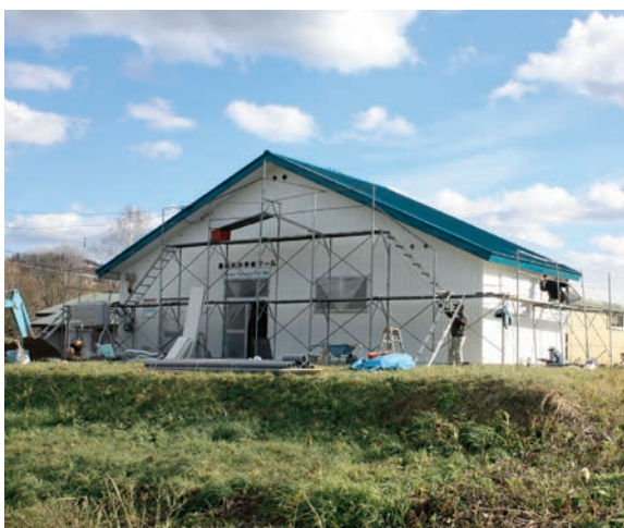
加工施設が整備されるSAF恩根内
