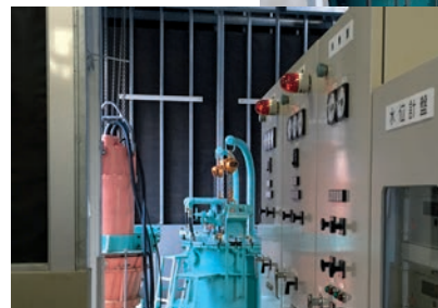
災害対策の重要拠点 美深9線救急内排水機場
