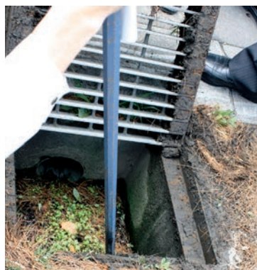
落ち葉等堆積している雨水枡
