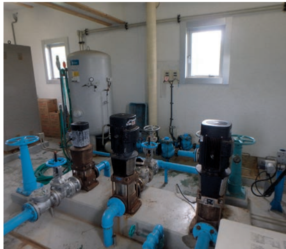
川西浄水場内部
