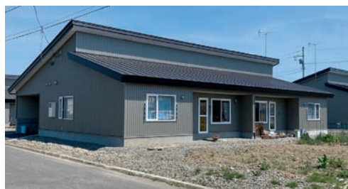
古くなり建て替えとなった公営住宅
