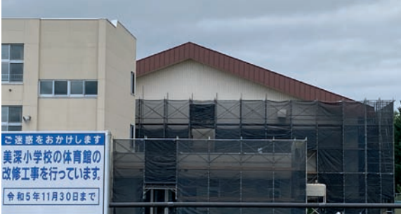
改修工事が始まった美深小学校体育館
