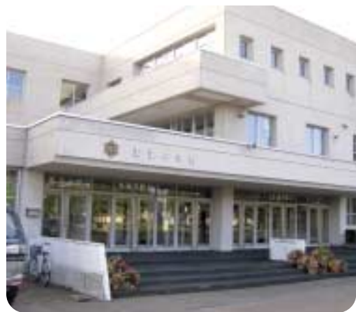
改築される美深中学校
