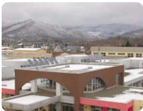
太陽光パネル設置の学校施設 (美唄養護学校)
