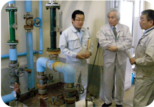
斑溪高台地区水道施設内部
