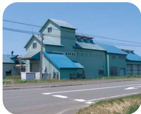
老朽化進む乾燥調整施設
