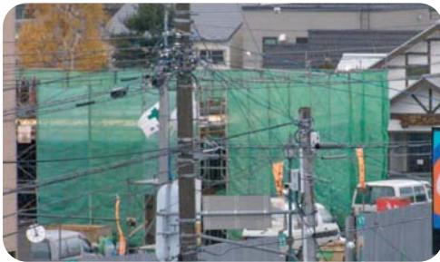
建設進む「ほっとプラザ・スマイル」 消防署屋上から撮影
