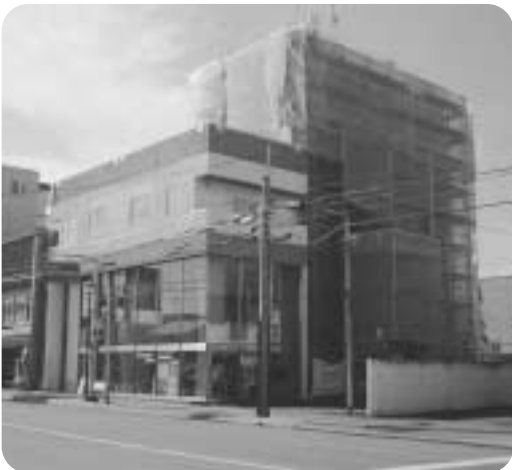
改築が進む店舗
