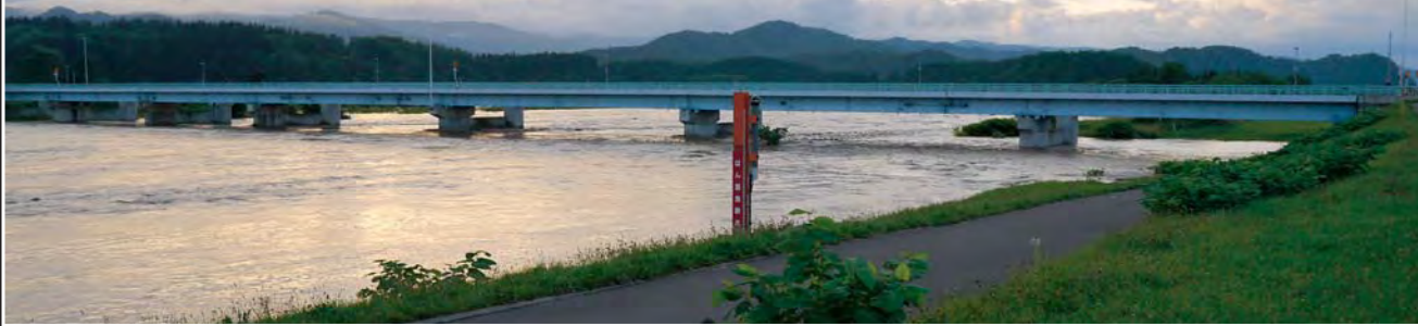
冠水した町道8線道路
