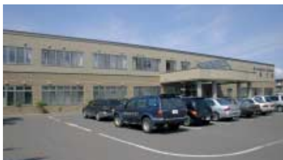
▲救急の受け入れを行う美深厚生病院
