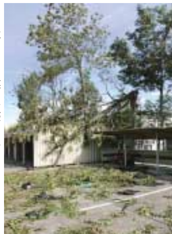
▶倒木による建物被害も多くありました
