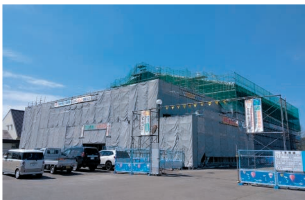
改修工事中の美深町民体育館(外観)
