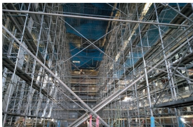
耐震補強工事中の美深町民体育館(アリーナ内)
