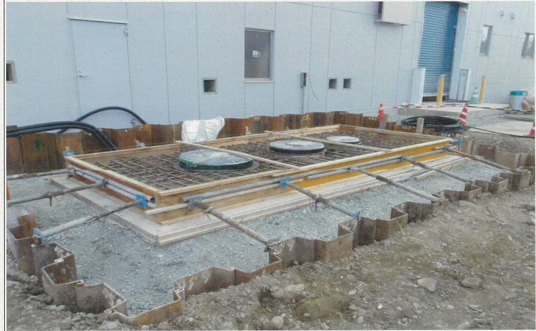
撮影箇所：⑩助燃油貯留槽土間配筋
